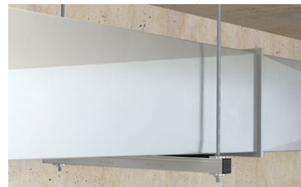
Installazione di canale di ventilazione.
