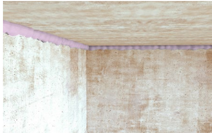
Giunti di chiusura in opere strutturali.
