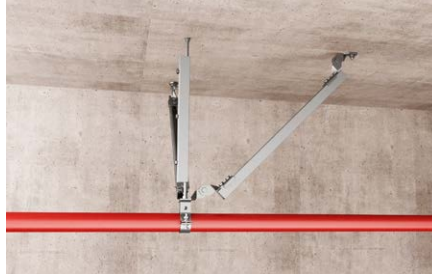
Installazione antisismica di tubi.
