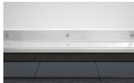
Fissaggio di scossaline in lamiera.
