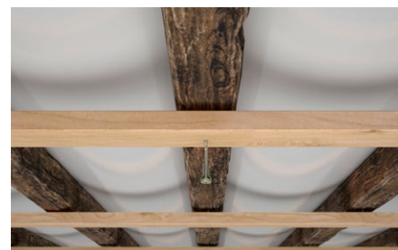
Sottostrutture per soffitti e controsoffitti.
