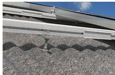
Detail upevnění s kombišroubem STSI
