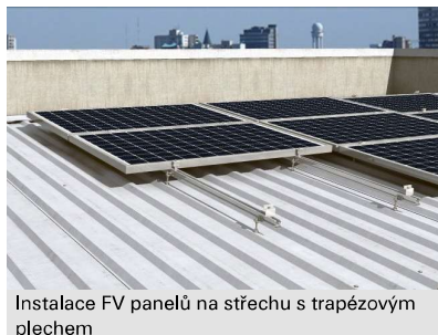
Detail upevnění s kombišroubem STSI
