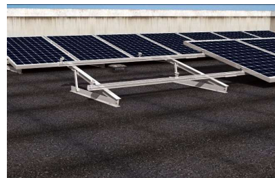
Detail konstrukce s trojúhelníkovými rámy
