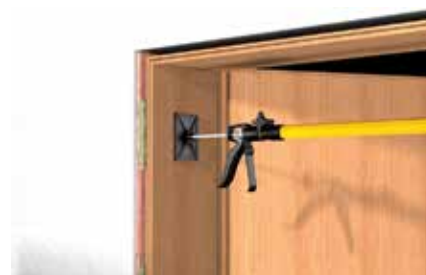
Schiumatura di telai di porte
