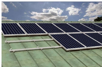
Upevnění solárních panelů s hliníkovými rámy
