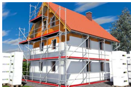
Incollaggio di pannelli isolanti per sistemi ETICS
