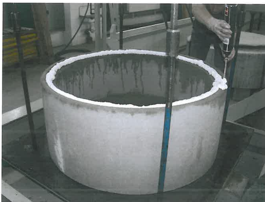
Bild 1: Brunnenschaumauftrag auf den Falz eines Schachtringes DN 1000
